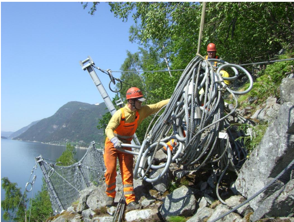
Bild 2: Materialtransport mit Hubschrauber
